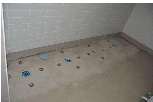
InviSense ja Smartrac antureita saunan suihkuhuoneessa
