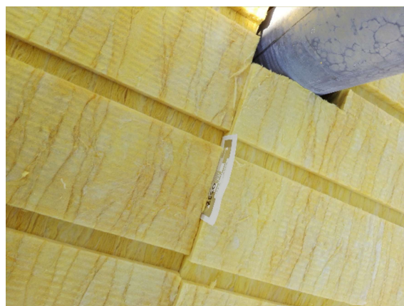
Anturin ujuttaminen paikalleen
