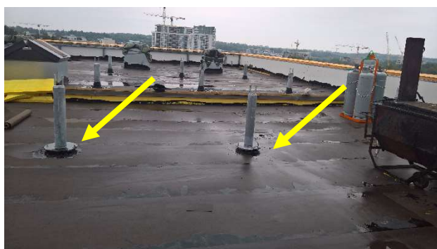
Antureita asennettiin erityisesti riskikohtien läheisyyteen
