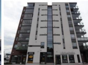
Katutasosta otettu valokuva on mallissa olevaa julkisivua tarkempi ja laadukkaampi.
